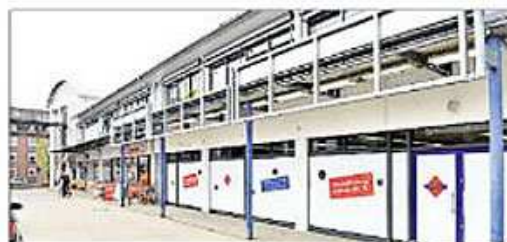
Die Geschäftsräume des ehemaligen ABC-Schuhladens werden derzeit renoviert.
